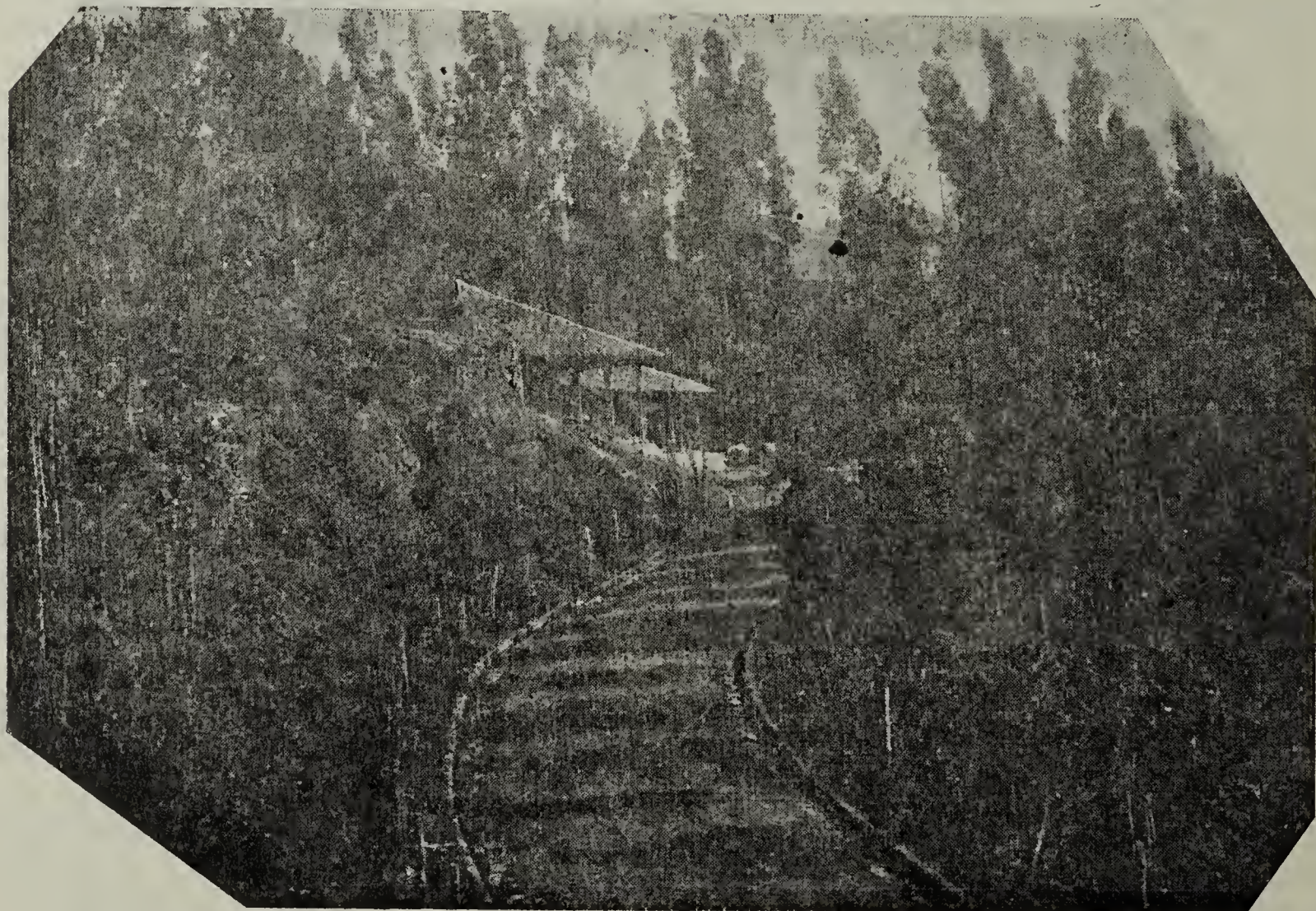
Salinas de Zipaquirá. Entrada a la mina.
